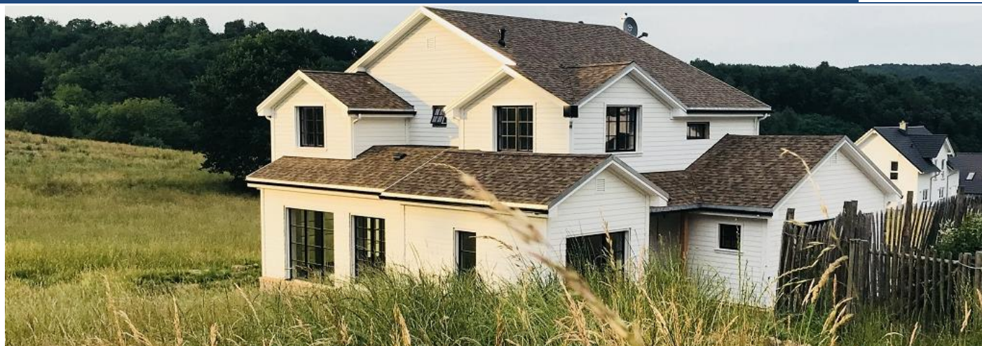
NEW FARM STYLE erbaut 2018 im Westerwald
