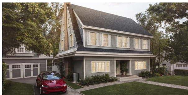
HAUS mit TESLA Solarschingles
