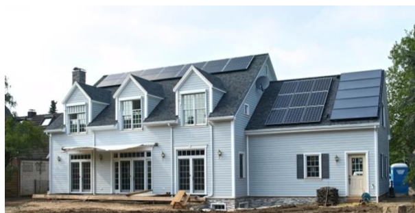
TWH Haus mit Photovoltaik und Brauch-Wasser-Solar
