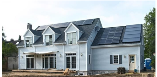
TWH Haus mit Photovoltaik und Brauch-Wasser-Solar
